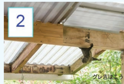
改装前の屋根
