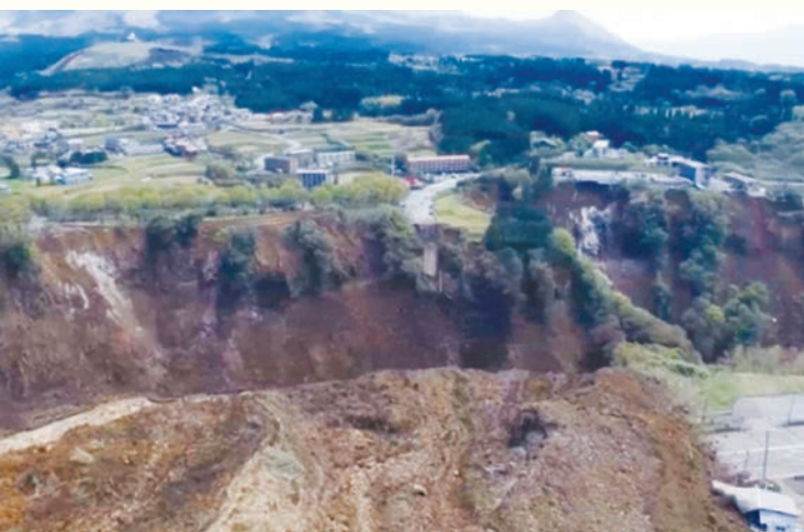
南阿蘇村立野 阿蘇大橋周辺の土砂崩れ箇所 国土地理院 4 月 16 日撮影
