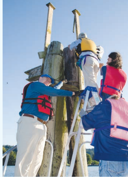
ボートの上から梯子作業
